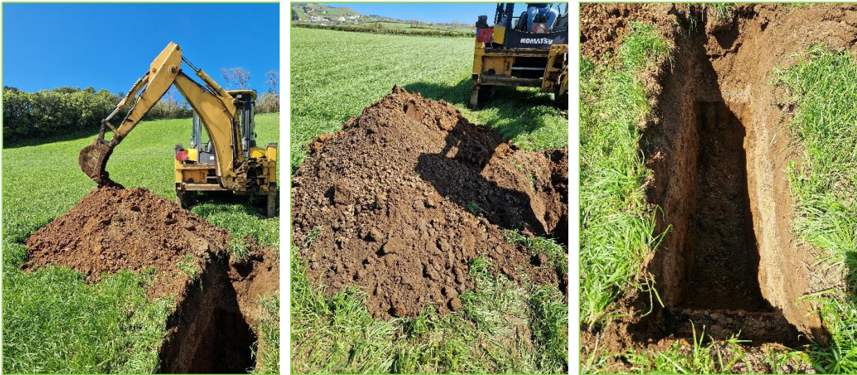
Figura 4.2 | Aspetos fotográficos dos poços de inspeção efetuados em “Lagoa Poente” (Labgeo, 19/03/2024)
